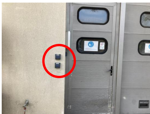
Buitendeur Technische dienst
